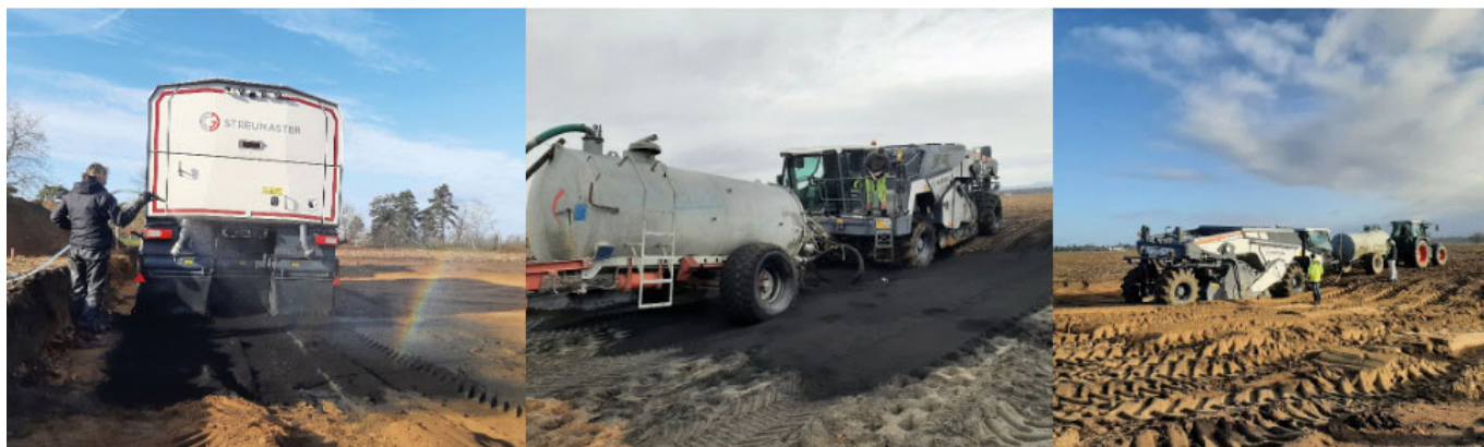
Abbildung: Immobilisierung der ungesättigten Bodenzone am Pilotstandort Hügelsheim. Das Sorptionsmittel wurde in definierter Masse pro Fläche aufgebracht und mit definiertem Wasservolumen pro Bodenvolumen durchmischt
