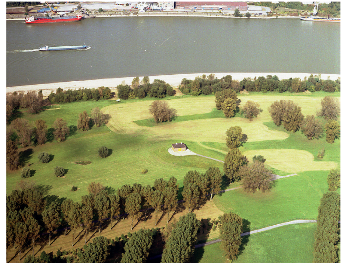
Wassergewinnung Auf dem Grind (Stadtwerke Düsseldorf AG): nachhaltige Grundwasserbewirtschaftung mithilfe von Indikatoren in innovativen Monitoring-Strategien bei Einzugsgebieten mit hoher Diversität in Landnutzung, Hydrogeologie und Bewirtschaftung. (Quelle: Stadtwerke Düsseldorf AG)
